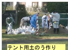
テント用土のう作り
