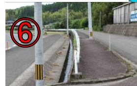
⑥ 木場建設下 増水時危険
