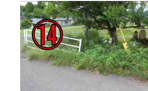
①④ ガードレール が途中からなく 、側溝のフタも なく危険
