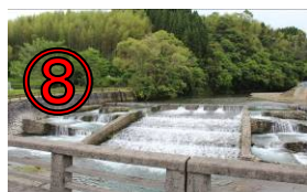
⑧ 親水公園付近 集中豪雨時危険
