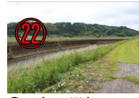
②② 穴野堤防 自転車通行禁止
