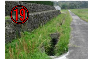
①⑨ 荒武さん宅付近 水路 深くてフタも無 いので危険
