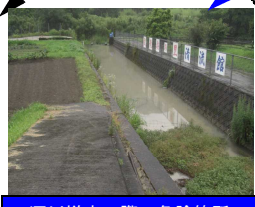
河川増水の際の危険箇所
