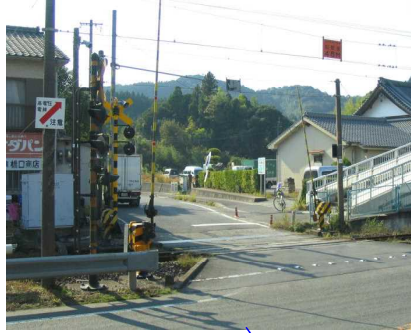
7 学校下踏切(水引小前)
