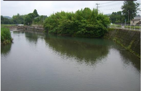
大宮神社前の堰付近 所々に深い部分があり危険
